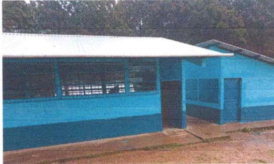
**Foto 1:** Cubierta de lámina con la instalación de láminas troqueladas calibre 26 en los módulos conforme las especificaciones establecidas.
