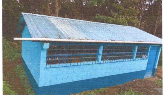
**Foto 2:** Láminas troqueladas calibre 26 instaladas en el módulo conforme las especificaciones establecidas.
