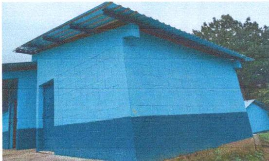
**Foto 3:** Láminas troqueladas calibre 26 instaladas en el módulo de cocina.
